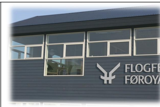
Hús við føstum og vindeygum at opna
