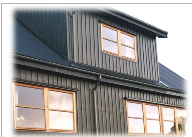
Vindeygu ið vísa "toppsving". Tvs. at vindeyga kann koppa runt so at t.d. útsíðan kann vaskast innanífrá.
