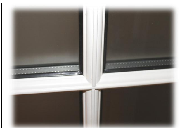
25 mm listar á glas, frá innsíðu. Eisini sæst "alu í glas", ið eftir ynski kann setast inn í glasið, so tað gevur fatan av gjøgnumgangandi listum, umframt at hetta styrkir glasið.
